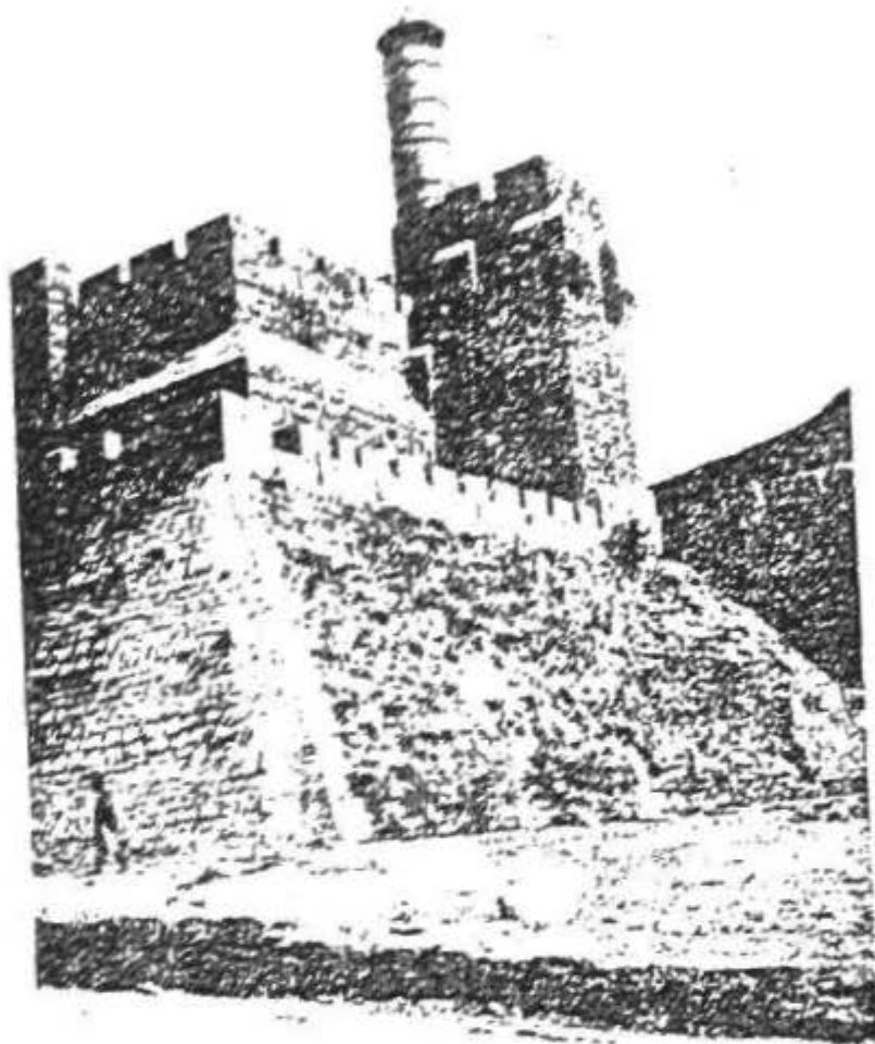
Fig. 112. LA LLAMADA «TORRE DE DAVID», DONDE SE HA- LLABA EMPLEZADO EL PALACIO DE HERODES
